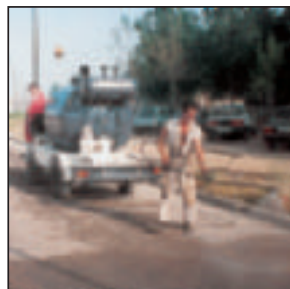
Equipo autopropulsado con cisterna 2.200 litros y riego por lanza.
