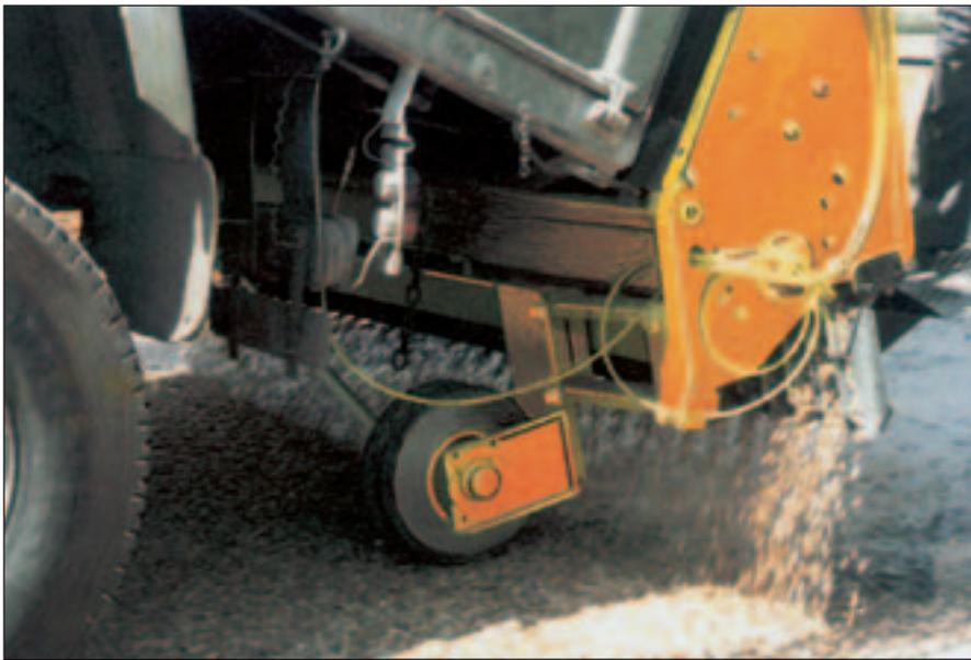
Rampa de distribución para el cambio del sentido de caída de la gravilla, frenándola y dejándola sin velocidad de caída sobre el ligante.
